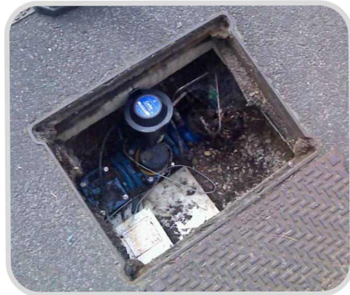
El Cello tiene un sofisticado régimen de alarmas para detectar e inmediatamente avisar de las condiciones anormales. El Cello admite alarmas para alto y bajo en cada canal. Adicionalmente, alarmas de perfil pueden ser configuradas para el seguimiento diario de los perfiles de datos. En la ocurrencia de la activación de una alarma, el Cello puede ser programado para que automáticamente, envíe los datos con mayor frecuencia.
